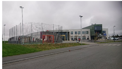
Figur 12 Utearealet ved inngangen
