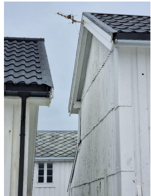
Figur 7: Eksempel på eternitt gavlvegg.
