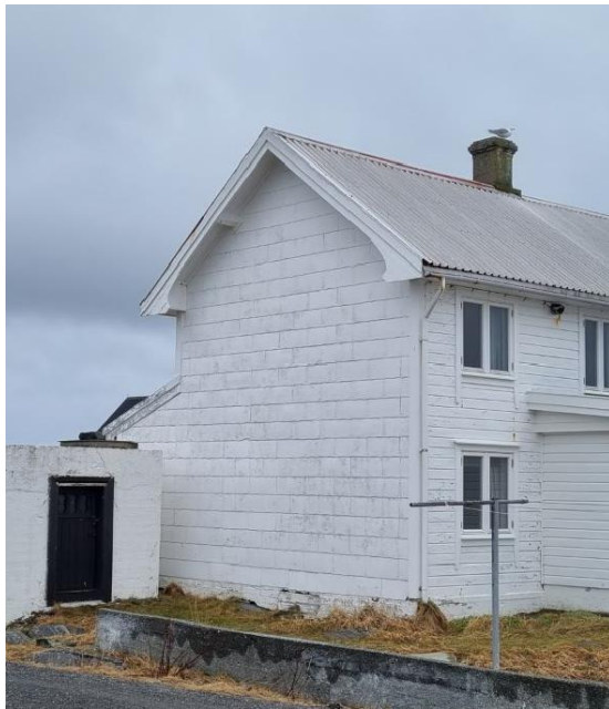
Figur 6: Eksempel på eternitt gavlvegg.
