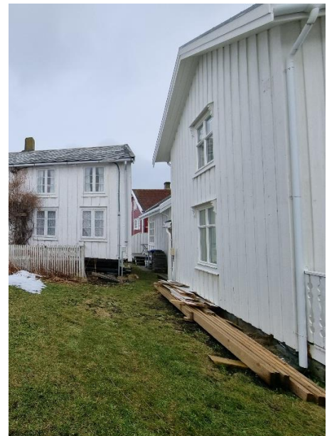
Figur 19: Byggevarer og annet brennbar bør ideelt plasseres i noe avstand fra trevegg.
