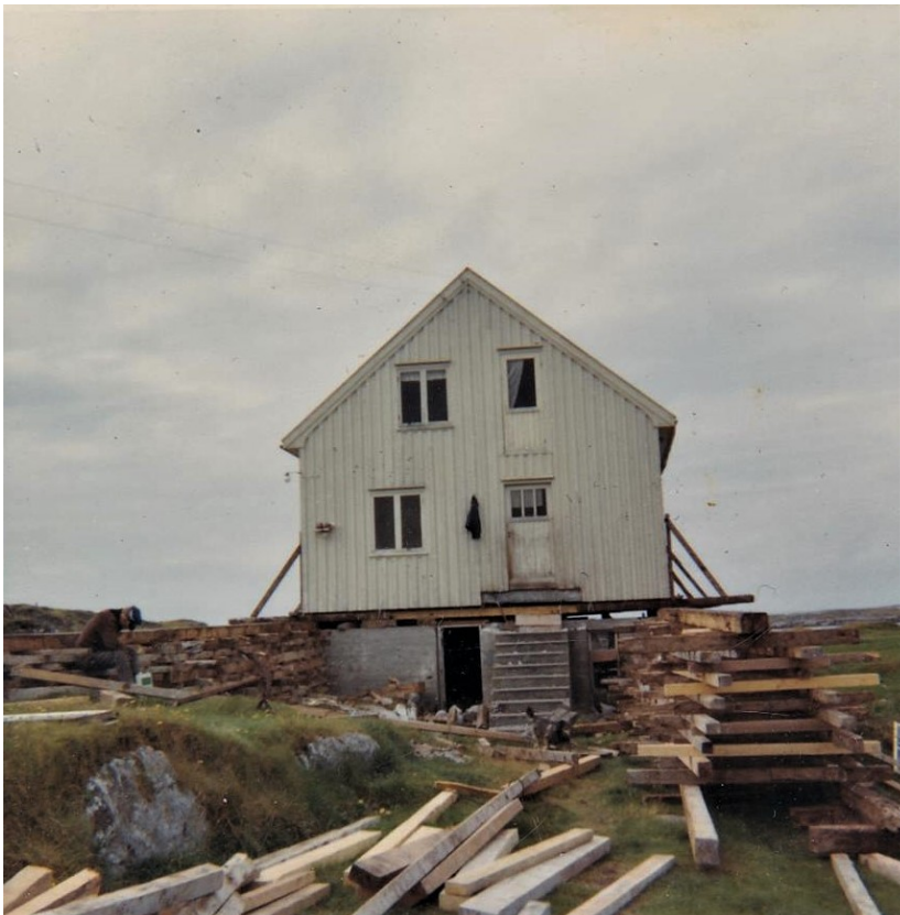
Her er alt gjort klart til husflytting av Kveldro på Nedre Orholmen til Stensøya i 1966. Eiere av huset var Dagmar og Nils Arnfinn Reitan, og etter flyttingen fikk huset navnet Sjøtun.
