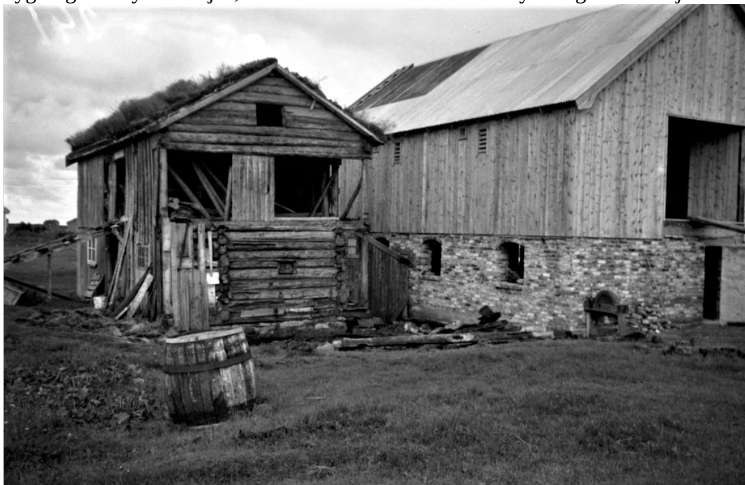
Bilde fra Kirkenes på Hopen fra august 1941. Gammel og ny tid møtes i dette bildet. Her er nyfjøset snart ferdigbygd og det gamle under rivning. I framgrunnen ser vi vasstønna, og ved det nye fjøset ser vi slipesteinen.
