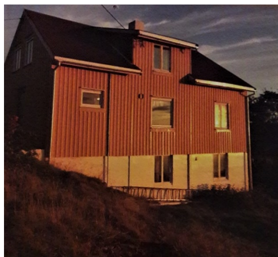
Huset fra Brattholmen der det fremdeles står på Stensøya.
