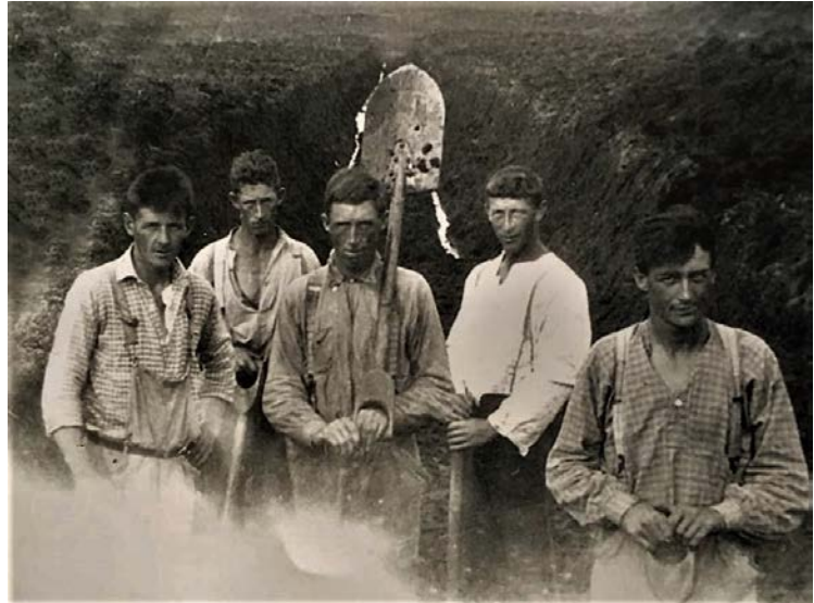
Kanalbygging på Frostadheia.
