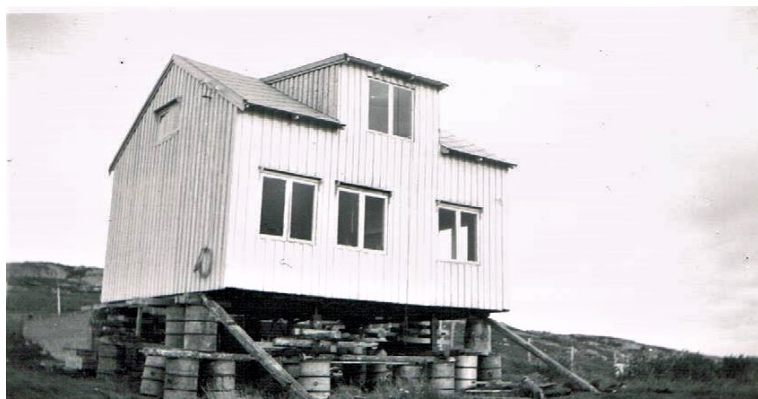
Huset trukket bort fra grunnmuren.
