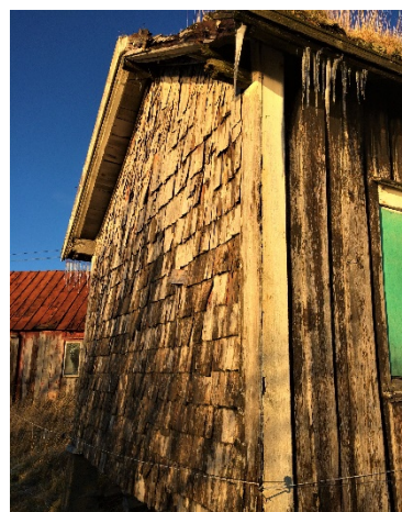
Spontekt sørside var vanlig på hus på Smøla i gamle dager.
