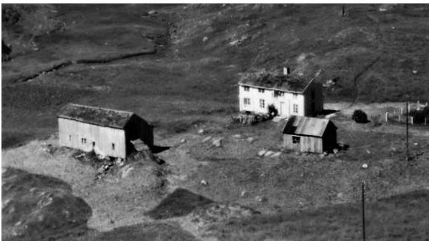
Husmannsplassen Nedre Vollen under Råket med våningshus, fjøs og eldhus. Bildet er tatt i 1963 av Widerøes flyselskap.
